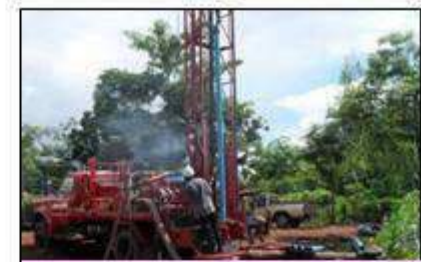
ขุดเจาะหลุมน้ำบาดาล
