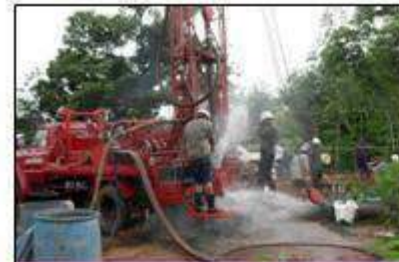
ขุดเจาะหลุมน้ำบาดาล
